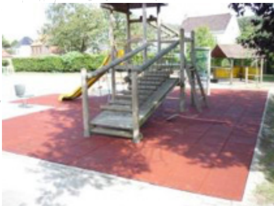
RUBBEREN TEGELVLOER ONDER DE SPEELTUIGEN
